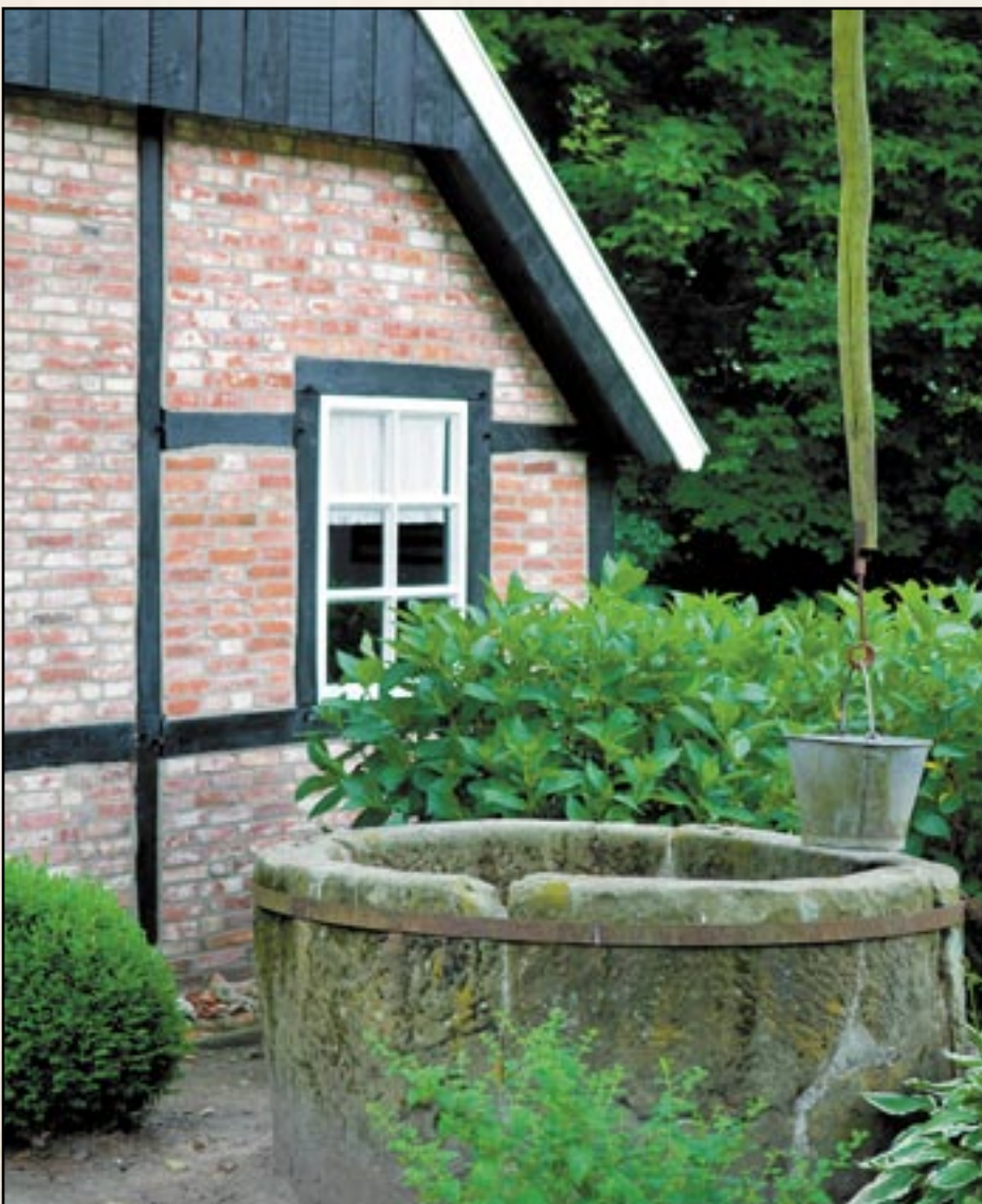
En grävd brunn med brunnskar av sandsten. Steblocken hålls på plats med hjälp av murbruk och järnband.
