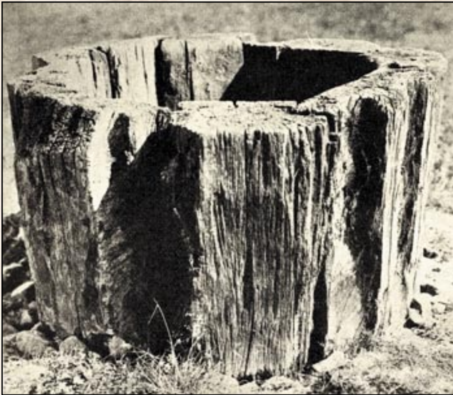
Brunn i stavkonstruktion. Illustration hämtad ur "En brunn i stavkonstruktion", Gerda Boethius, 1930.
