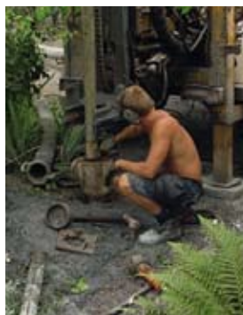
1. Borring av energibrunn
