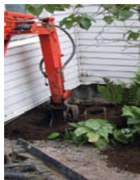
3. Grävning av dike fram till husvägg
