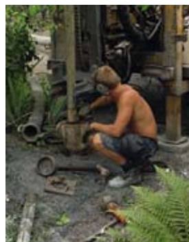
1. Borring av energibrunn
