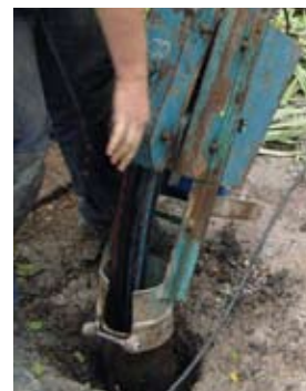
2. Kollektorns anslutning till energibrunn
