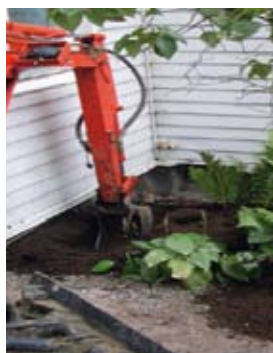
3. Grävning av dike fram till husvägg
